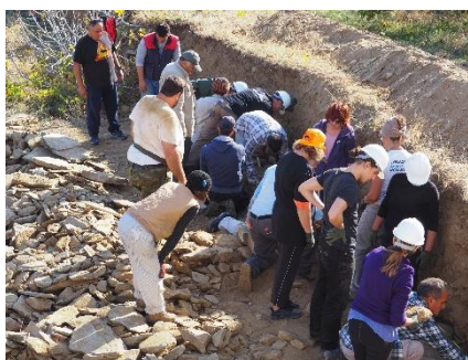
Εικόνα 2: Εργασίες κατά τη διάρκεια του 1ου Σχολείου Ξερολιθιάς Άνδρου, Νοέμβριος 2021 (φωτο: Παν. Αιγαίου)
