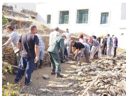
Εικόνα 3: Εργασίες κατά τη διάρκεια του 1ου Σχολείου Ξερολιθιάς Άνδρου, Νοέμβριος 2021 (φωτο: Παν. Αιγαίου)
