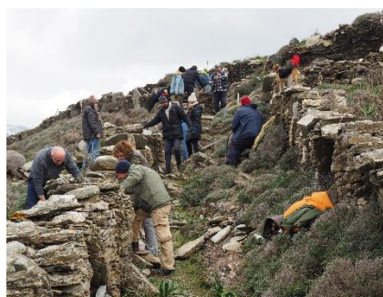
Εικόνα 4: Εργασίες κατά τη διάρκεια του 2ου Σχολείου Ξερολιθιάς Άνδρου, Μάρτιος 2022 (φωτο: Παν. Αιγαίου)
