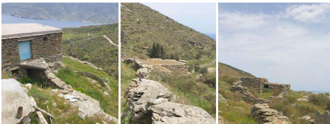
Εικόνα 26(α,β,γ) Κτίσματα στην διαδρομή Τ1, (Μαριγγέλα Γρηγορίου)
