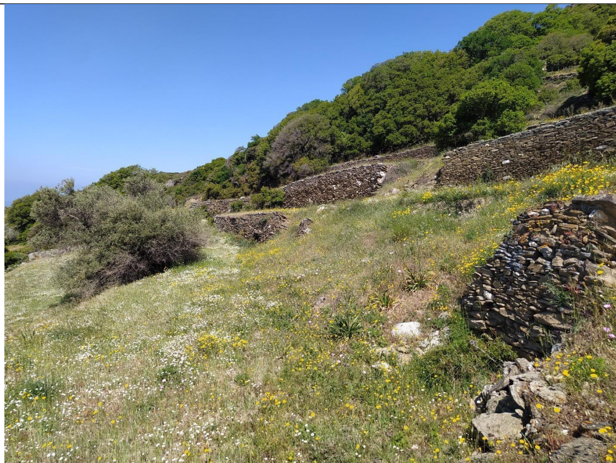
Ξερολιθιές τμήματα των οποίων έχουν καταρρεύσει (Αγροτεμάχιο 093)
